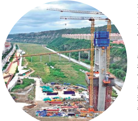
正在建设的铎山大桥
